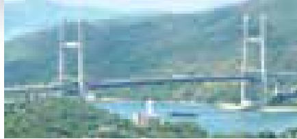
10月23日 青嶼幹線首次口封，汲水門大橋位於馬灣的橋塔。
