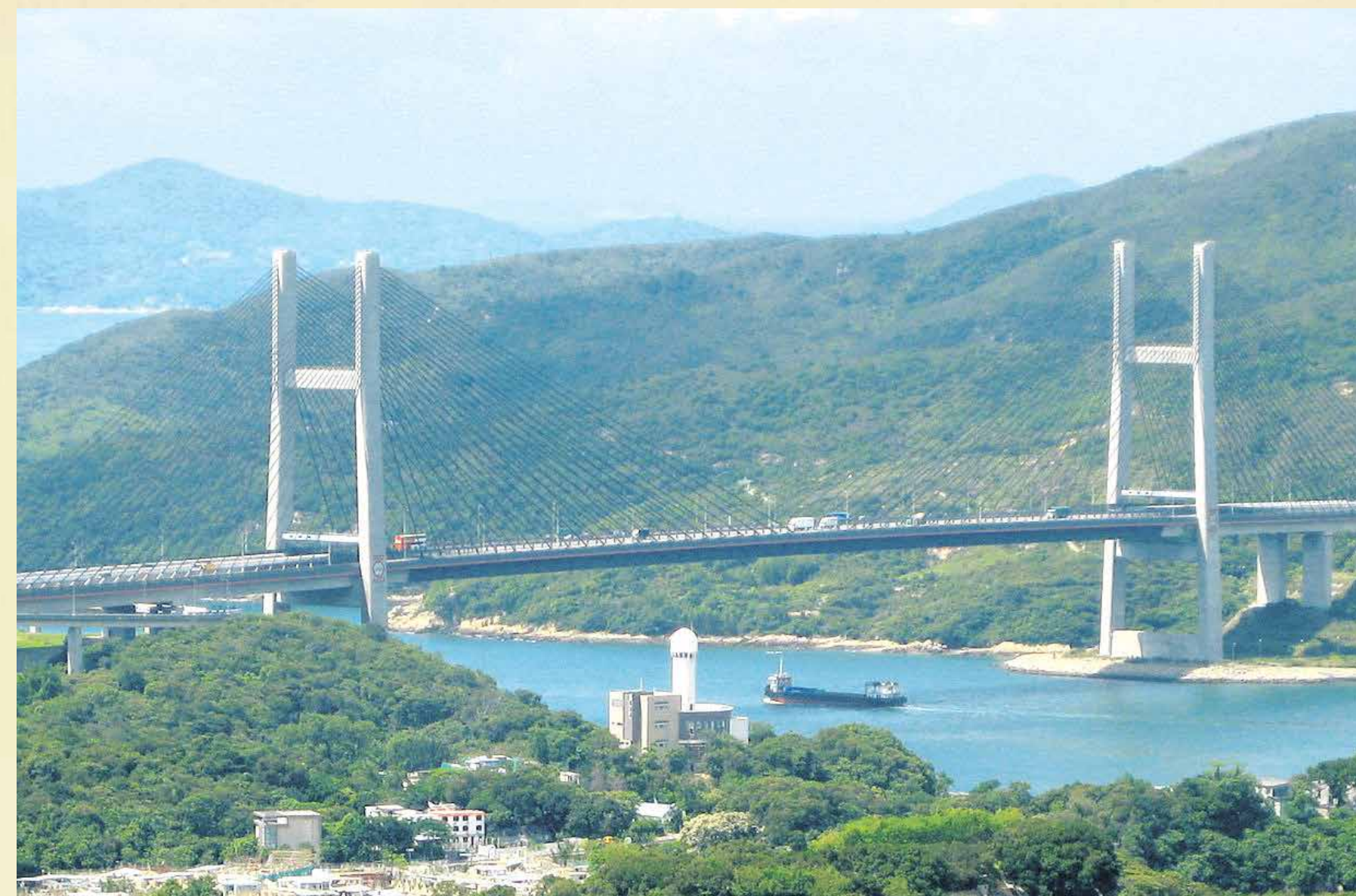
10月23日 青嶼幹線首次全封，汲水門大橋位於馬灣的橋塔。
